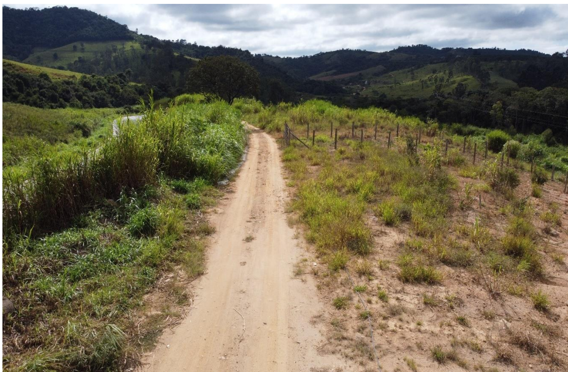
Foto aérea de vicinal rural tipo II localizada na zona rural do município de Guaxupé/MG.
